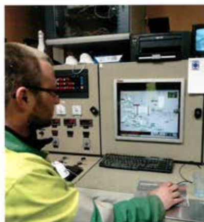
Poste de pilotage de l'usine.
